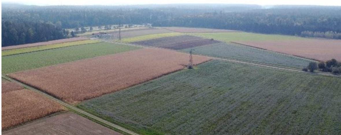
Abbildung 43: VZ Hohenbrugg, Blickrichtung Süden; 110 kV-Leitung führt zum Umspannwerk Hohenbrugg (Aufnahme: A17)
