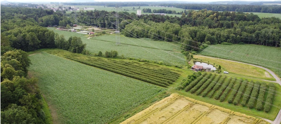
Abbildung 94: Nördlicher Teil der VZ Seibersdorf, Blickrichtung Nordwesten; 380 kV-Leitung (Aufnahme: A17)
