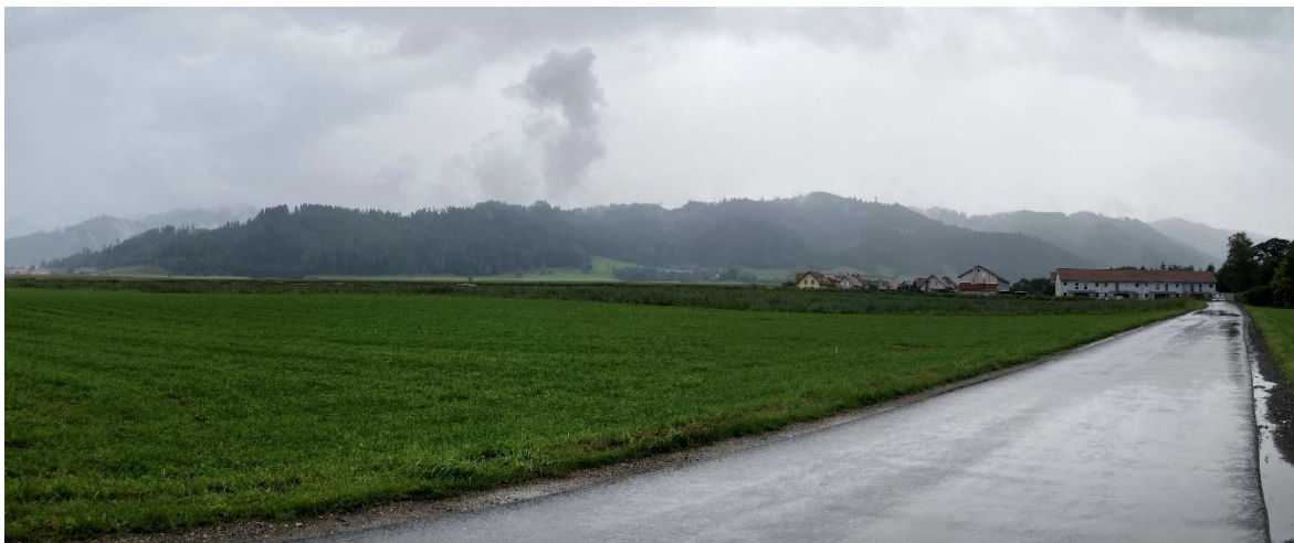
Abbildung 25: VZ Fohnsdorf; Blick über den mittleren Teil der VZ zur Siedlung Pölsweg (links) und zum Falkenberg. Blickrichtung West (Aufnahme: A17)
