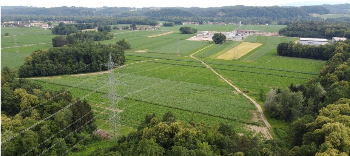
Abbildung 96: Südlicher Teil der VZ Seibersdorf; Blickrichtung Süden (Aufnahme: A17)
