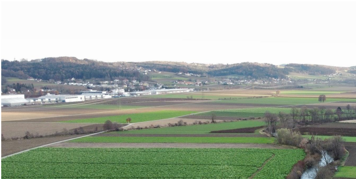
Abbildung 76: Blick zum südlichen Teil der VZ Pirching, Blickrichtung Südosten; gut ist die 380kV Steiermarkleitung erkennbar (Aufnahme: A17)
