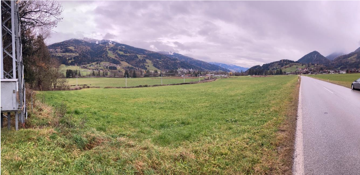
Abbildung 119: Nördlicher Teil der VZ Weißenbach; Blickrichtung Westen. Am rechten Bildrand ist die Ortschaft Weißenbach erkennbar; die linke Bildhälfte quert die Bahnlinie Selzthal - Bischofshofen (Aufnahme: A17)
