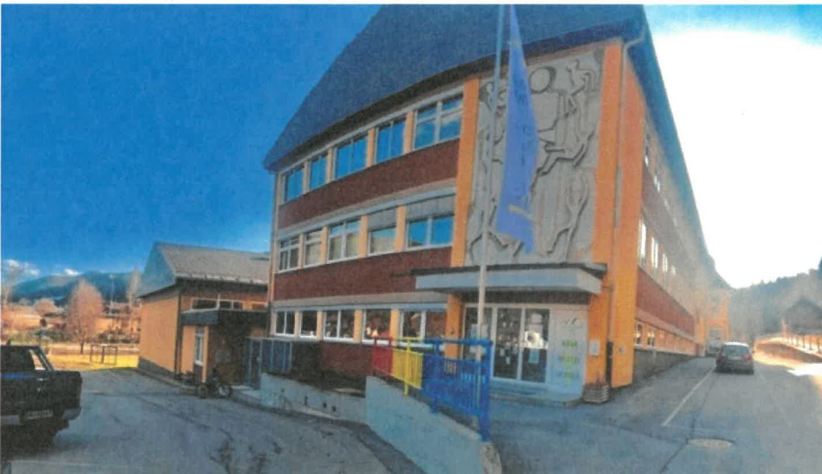
Die Volksschule Stadl an der Mur (Bild: Kevin Geißler)
