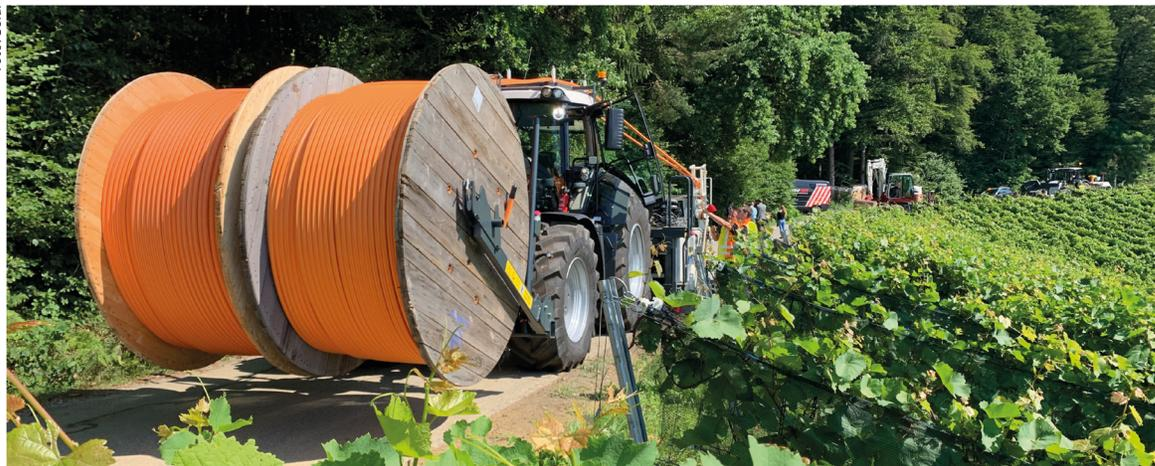
Mit dem „Layjet“ werden die Glasfaserkabel in der Region verlegt.
