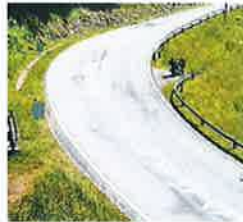
Balken wirken auf der Soboth schon
