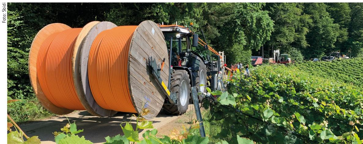
Mit dem „Layjet“ werden die Glasfaserkabel in der Region verlegt.
