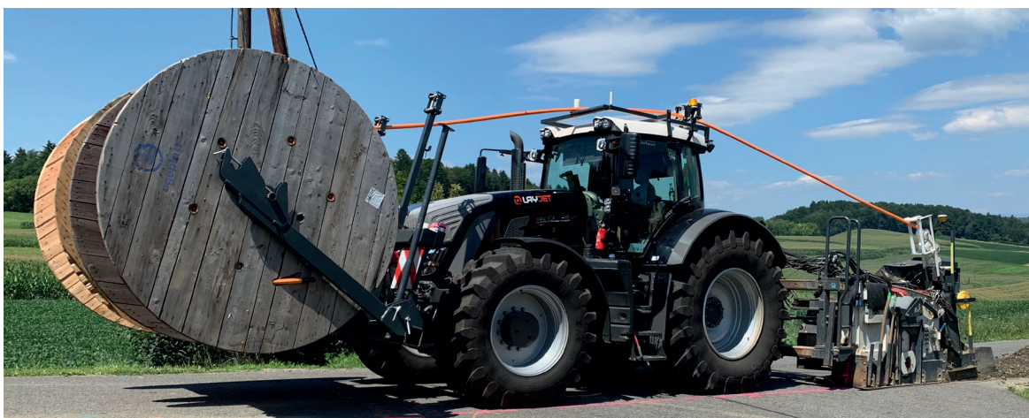
Der „Layjet“ beschleunigt die Verlegung der Glasfasernetze in der Steiermark.
