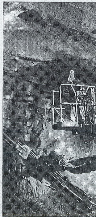
Noch vor 2000 Baubeginn? Zweite Plabutsch-Tunnelröhre FOTO: WOLF
